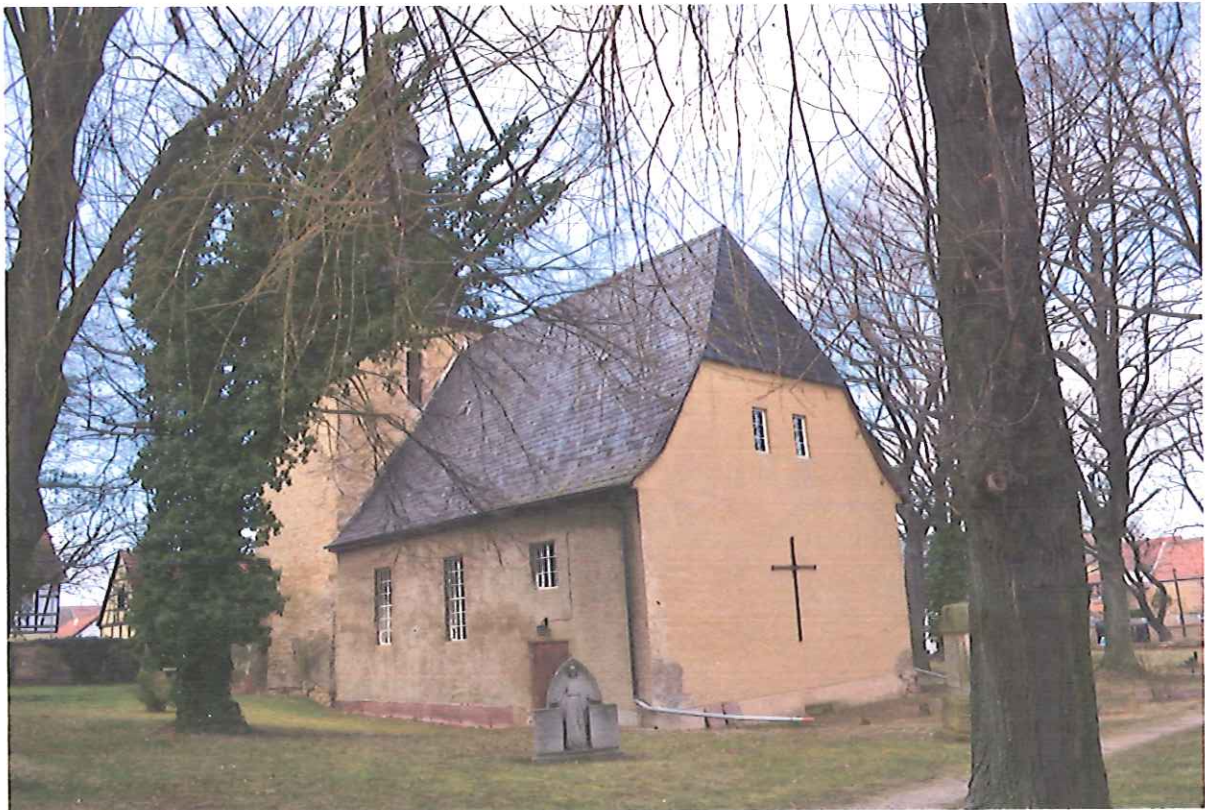
Blick von Süd-Osten
