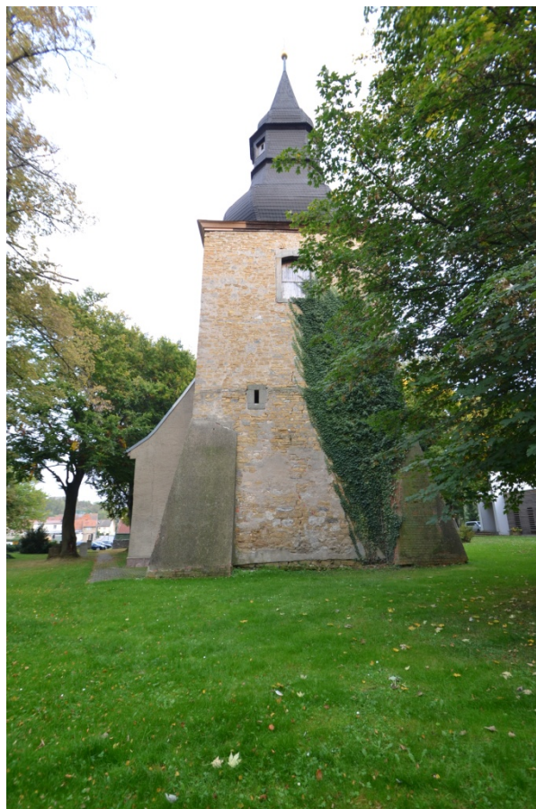
Kirche zum Hl. Kreuz, Blick vom Standort des geplanten GEMEINDEHAUSES mit seiner Pergola an der Nordseite auf den Westturm, wo im BA 2 ein Zugang geschaffen werden könnte, 28.09.2017
