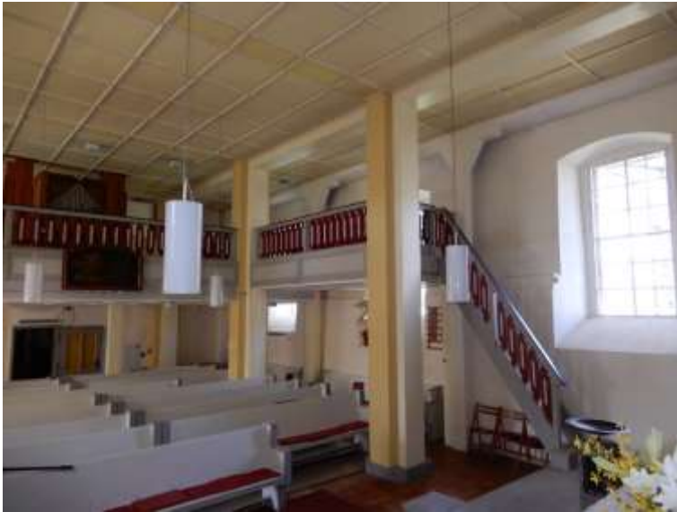
Bild 3: Ansicht Säule Nordseite
